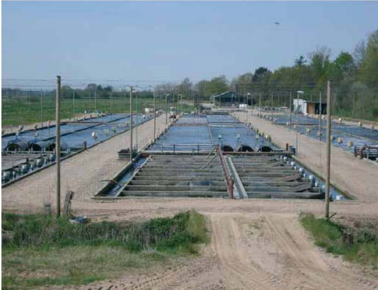
Figur 14. Kongeåens modeldambrug type 3. Produktionsenhederne omfatter 3 sektioner, der hver består af 2 beton raceways med mikrosigter (maskestørrelse 74 \mu\text{m} ) foran biofilter sektionerne (forgrunden). I baggrunden til venstre ses plantelagunerne bestående af de tidligere jorddamme og indløbs- og udløbskanaler (Svendsen et al., 2008). Foto: Lars M. Svendsen.
